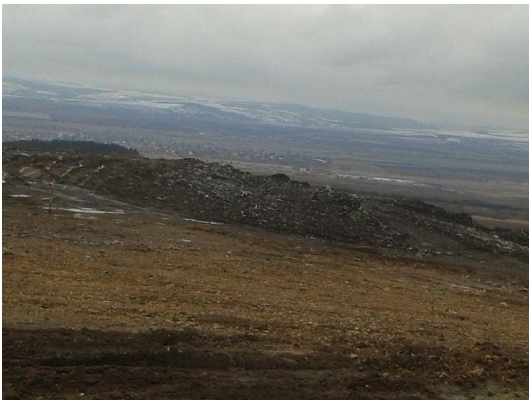
Figura 2-7: Zona curățată de deșeuri și nivelată (văzută de la nord)
