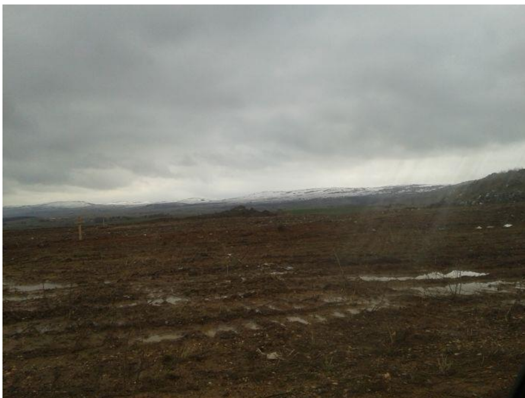
Figura 2-6: Zona curățată de deșeuri și nivelată
